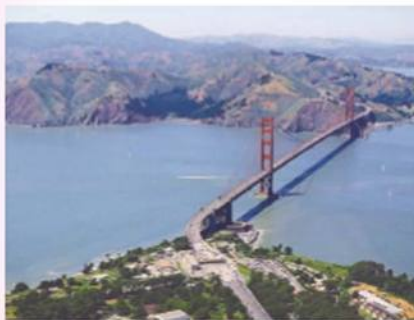
Рис. 149. Мост через пролив Золотые Ворота
